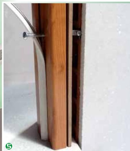
A porta é parafusada nos cavalotti que previamente foram nivelados. Os parafusos podem ser escondidos nas juntas ou com pinos coloridos **TECNICO**.
