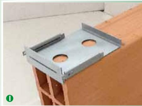
A tecnologia "**TECNICO**" consiste em colocar a placa de metal, chamada de **STAFFA** entre os tijolos durante a construção da parede
