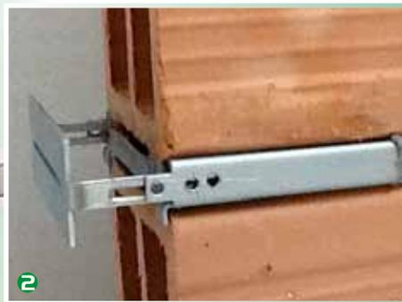
Cavalotto permite corrigir qualquer imperfeição da parede.
